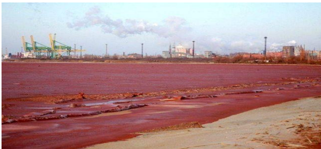
Рис 1. Руйнування греблі шламосховища Миколаївського глиноземного заводу.
